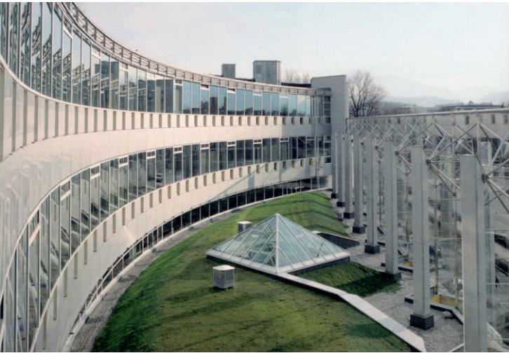
Abb. 1: Stadt Salzburg, Salzburg, Wüstenrot Versicherungs-Center, Bürokomplex Pyramide Foyer, Lärmschutzwand
